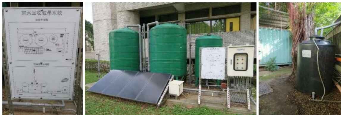
元智二館雨水管收集過濾 - 利用太陽能與市電共用運作，因容積有限，目前做為輔助應用與教學示範
