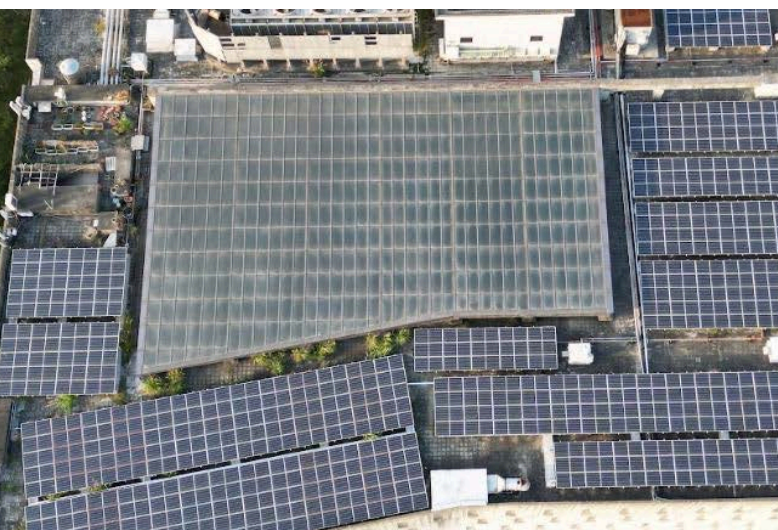
七館頂樓太陽能裝置
